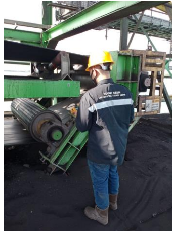
Gambar 1 Pengecekan langsung terhadap komponen belt conveyor.
