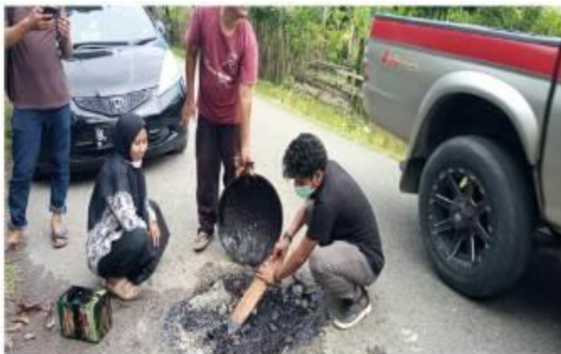
Gambar 5. Pelaksanaan penuangan campuran aspal
