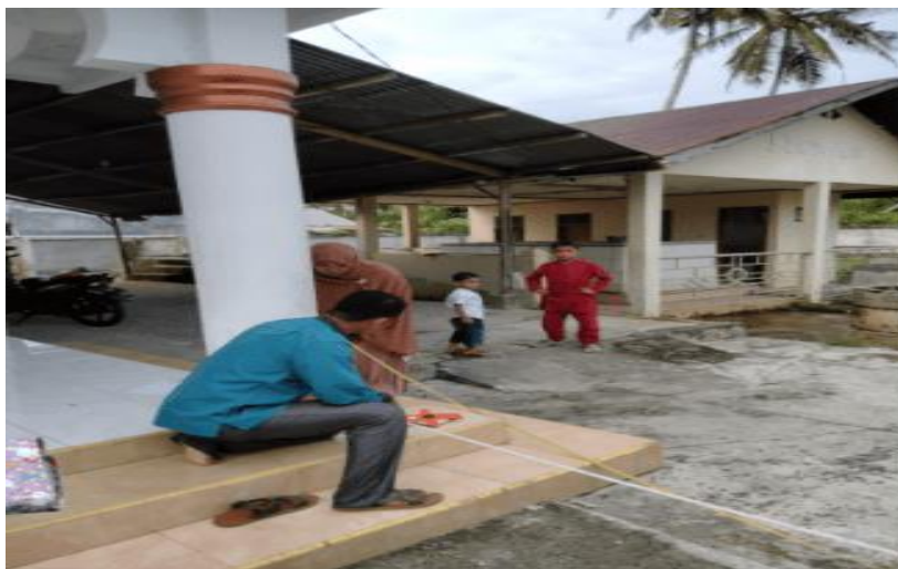
Gambar 1. Pengukuran luas Bangunan
