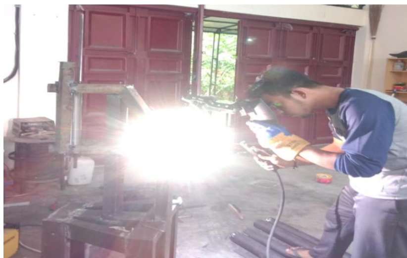
Gambar 3. Proses Pembuatan Alat Power Forging Hammer
