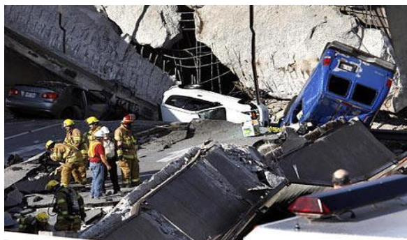
Gambar 1. Jembatan layang (highway) yang ambruk di Quebec , Kanada, tahun 2006 yang salah satunya disebabkan oleh efek korosi [6]
