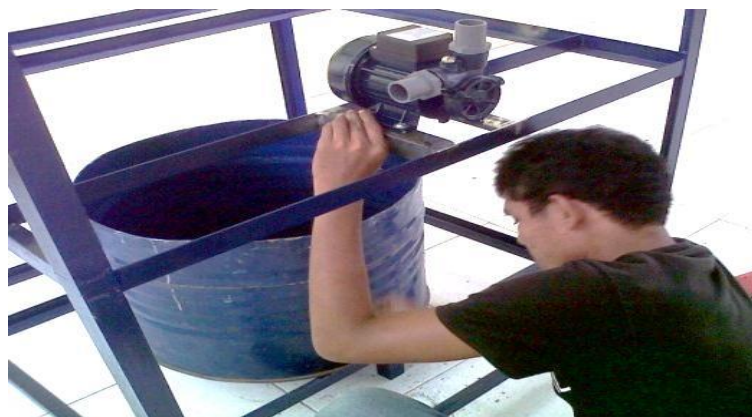
Gambar 13. Pemasangan pompa air
