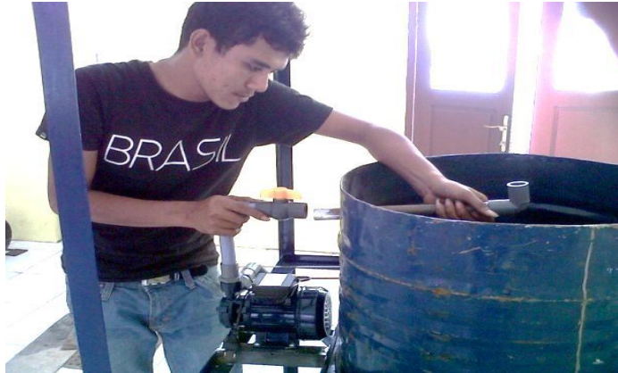
Gambar 14. Pemasangan instalasi pipa
