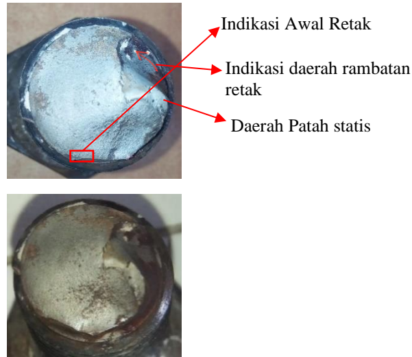
Gambar 5. Permukaan Patahan Baut
