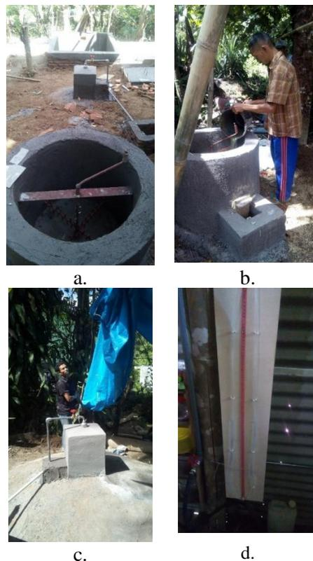
Gambar 1 a. bak pengadukan kotoran sapi, b. proses pencampuran kotoran sapi dengan air, c. tangki digester kapasitas 4 m<sup>3</sup>, d. pengukuran tekanan gas menggunakan manometer sederhana.
