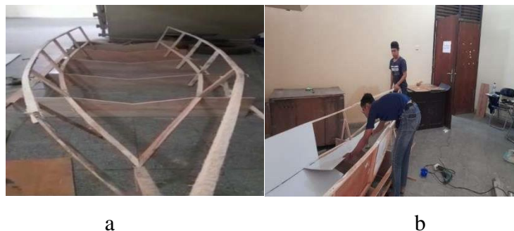
Gambar 3. Pembuatan Cetakan : (a) Pembuatan kerangka cetakan, (b) Pemasangan alas cetakan
