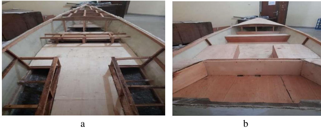
Gambar 5. Pemasangan lantai : (a) Pemasangan kerangka, (b) Pemasangan lantai
