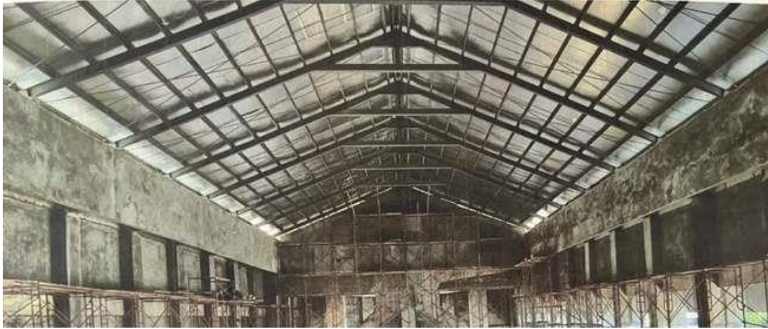
Gambar 2. Struktur Rangka Atap Eksisting Gereja Katedral Jayapura
