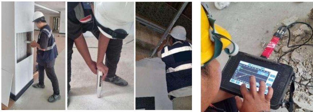
Gambar 2. Titik Pengujian Hammer Test dan UPV ( gambar lapangan )
