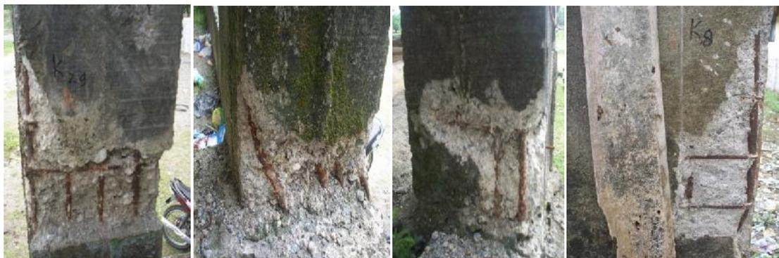
Gambar 7. Kondisi kolom mengalami pengapuran
