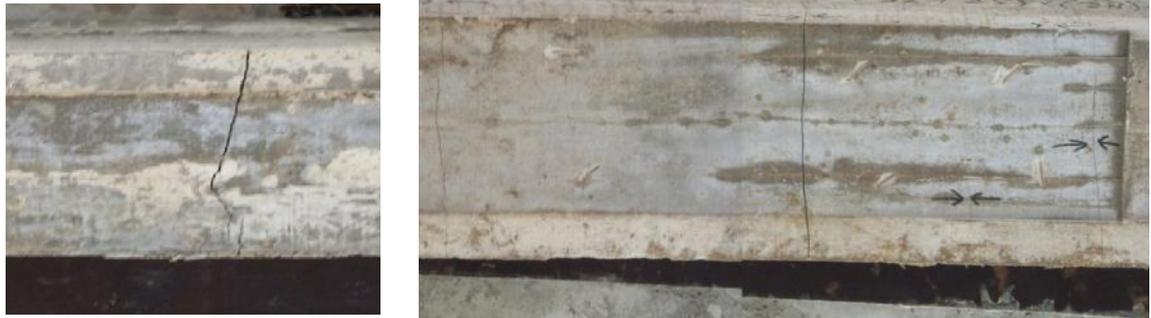
Gambar 8. Kondisi retak pada balok
