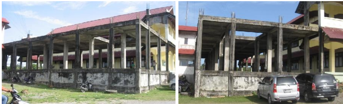
Gambar 2. Tampak Bangunan Gedung Bank Aceh Cabang Pidie
