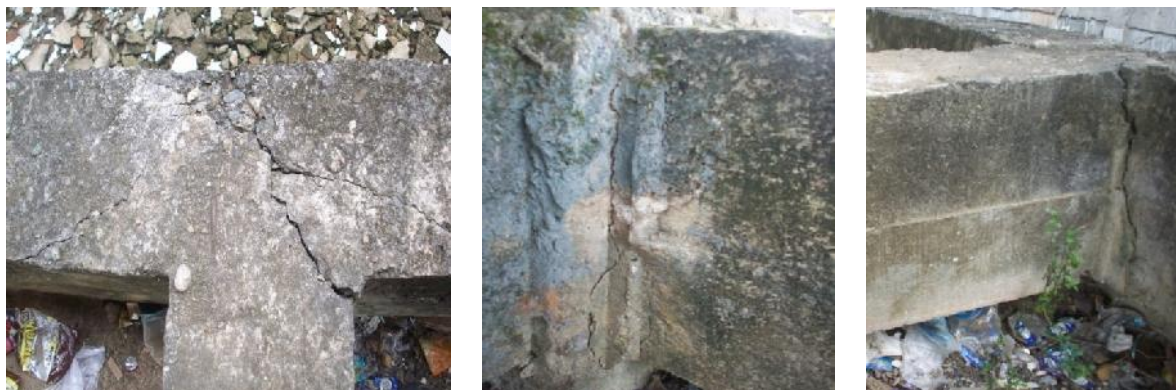
Gambar 5. Kondisi sambungan pada sloof melintang dengan sloof memanjang
