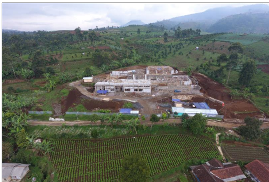
Gambar 3 Progress 35 % proyek menggunakan kamera drone
