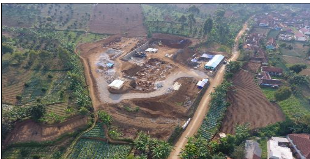
Gambar 2 Progress 20 % proyek menggunakan kamera drone
