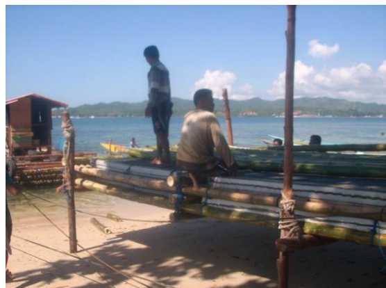
Gambar 2. Memasang bambu pada lapisan atas rumpon
