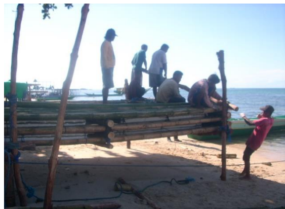
Gambar 4. Memasang kayu balok melintang di atas rumpon
