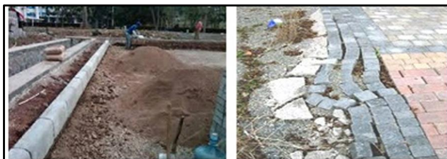
Gambar 3. Pemasangan penguat tepi jalan
