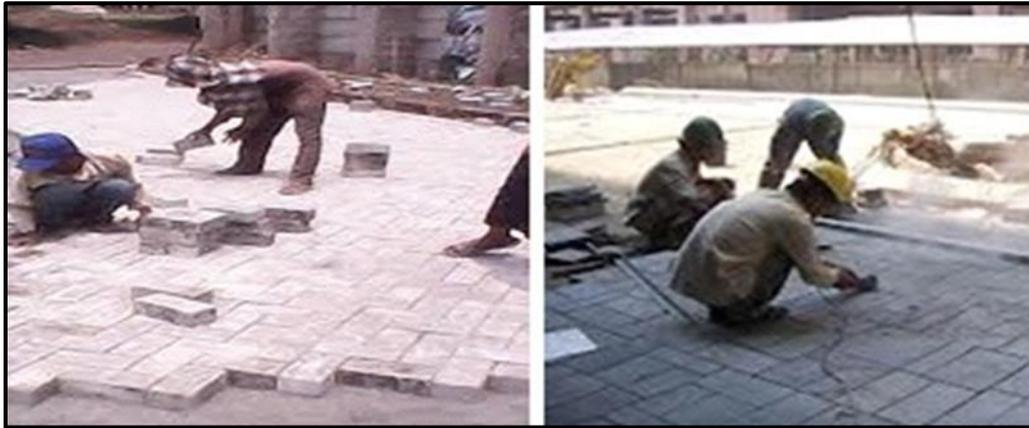
**Gambar 6.** Posisi pekerja dalam pemasangan.
