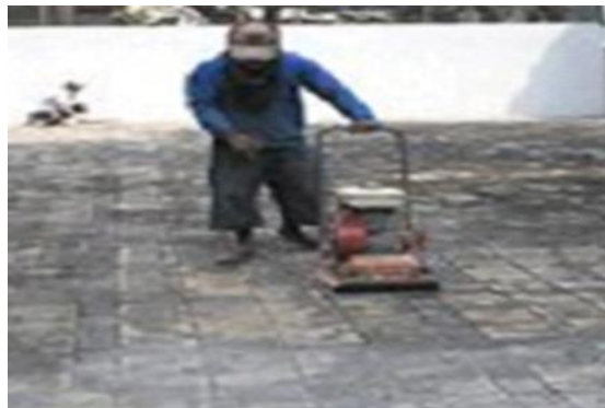
Gambar 7. Pemadatan paving dengan Mesin Plat Compactor (Stamper Kodok)
