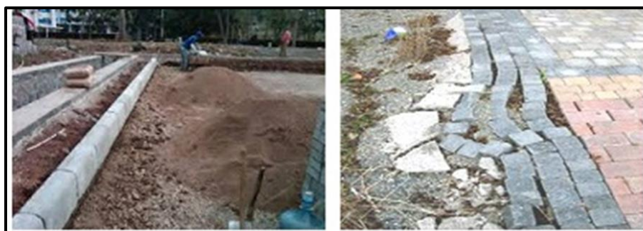
Gambar 3. Pemasangan penguat tepi jalan
