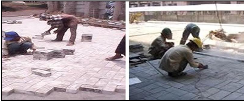
Gambar 6. Posisi pekerja dalam pemasangan.
