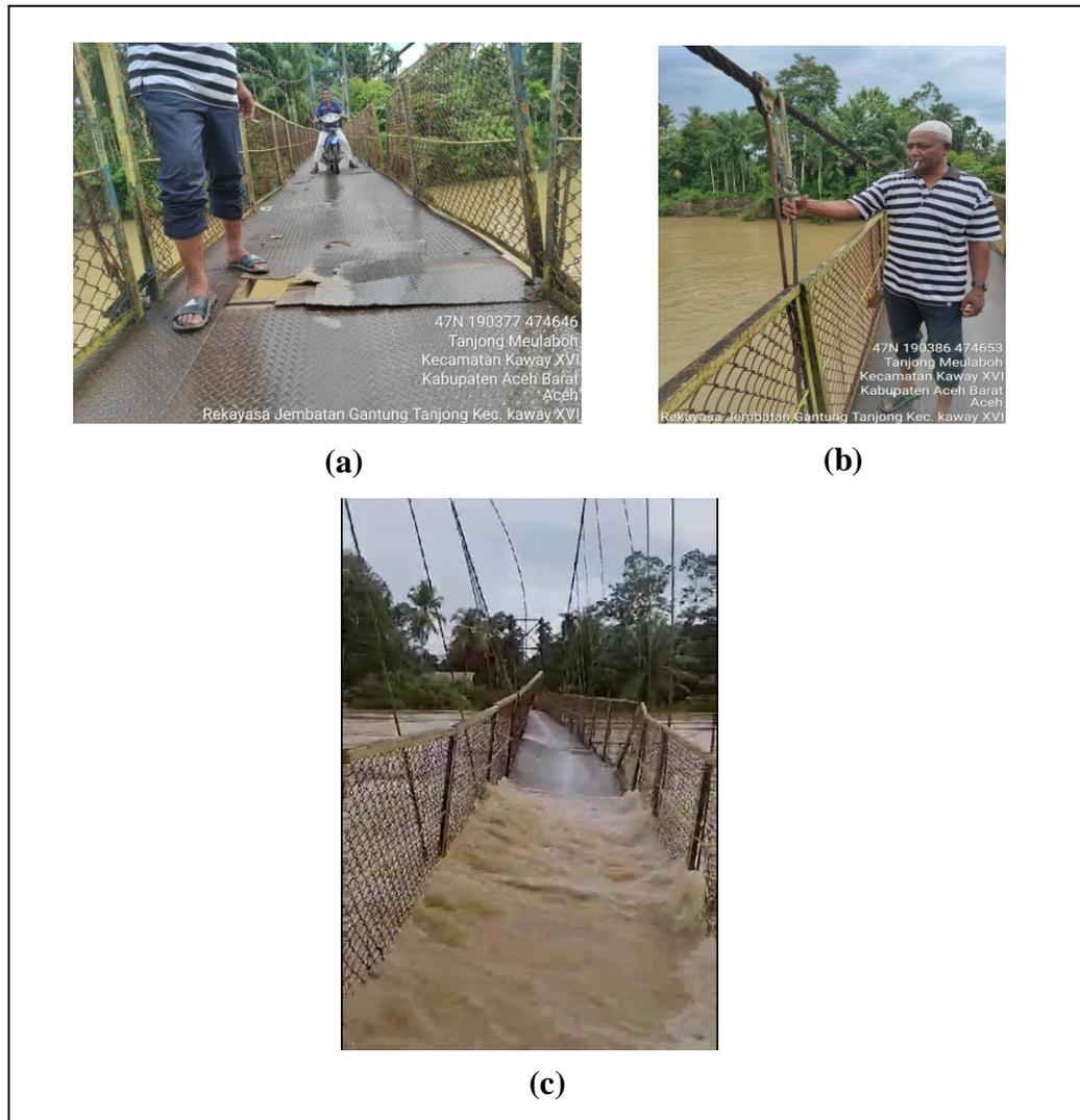
**Gambar 1. Peninjauan Jembatan Gantung di Desa Tanjung Meulaboh: (a) Kerusakan lantai jembatan; (b) Kerusakan Gantungan jembatan; (c) Bencana Banjir**
